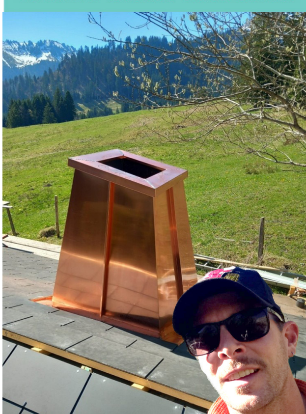
Réfection d'une borne au Chalet de la Rudaz au Pâquier. Photo : R.C.
