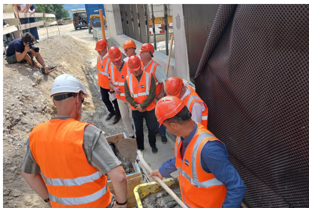
Pose du cylindre contenant des plans et des informations sur le Foyer St-Joseph écrites par les résidents !
