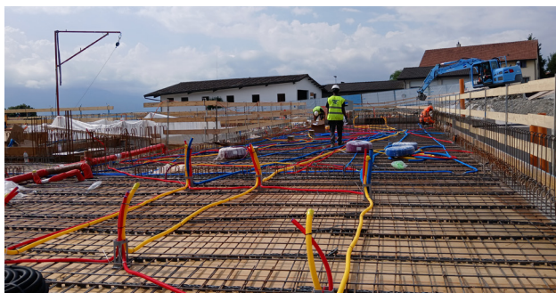
Vue d'une partie du chantier
